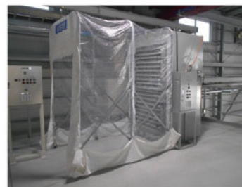
気吹き作業 ADC-601 小型アコーディオンルーム
