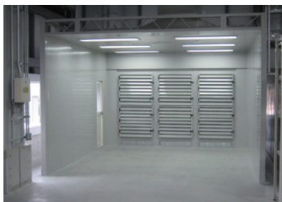
サンディング作業 ADC-403 中型パネルフード 蛍光灯
