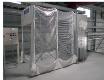
気吹き作業 ADC-401 小型アコーディオンルーム
