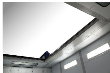
スライド扉を開けた天井開口面
